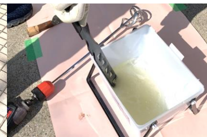
④塗料、骨材を調合及び攪拌
