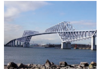
東京ゲートブリッジ
