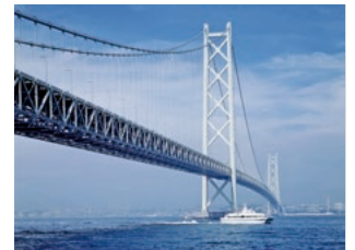
明石海峡大橋
