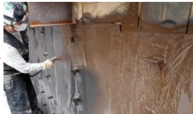
④ ガスファルト吹付け
