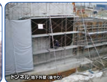
トンネル 地下外壁 (後やり)
