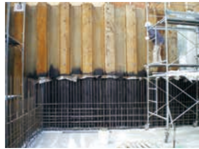
シートパイル
