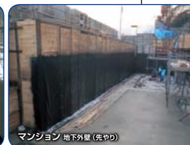
マンション 地下外壁 (先やり)
