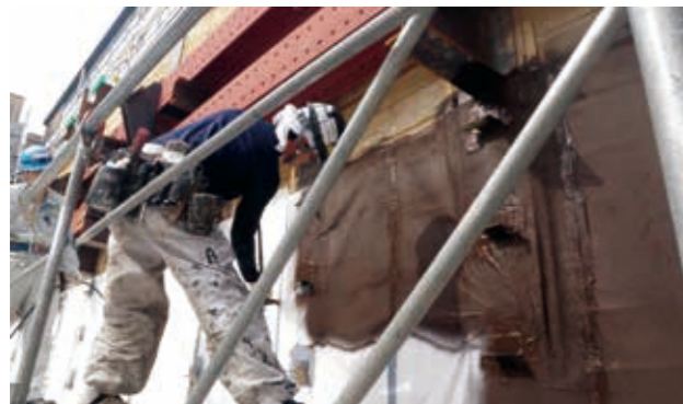
③ ガスファルト吹付け
